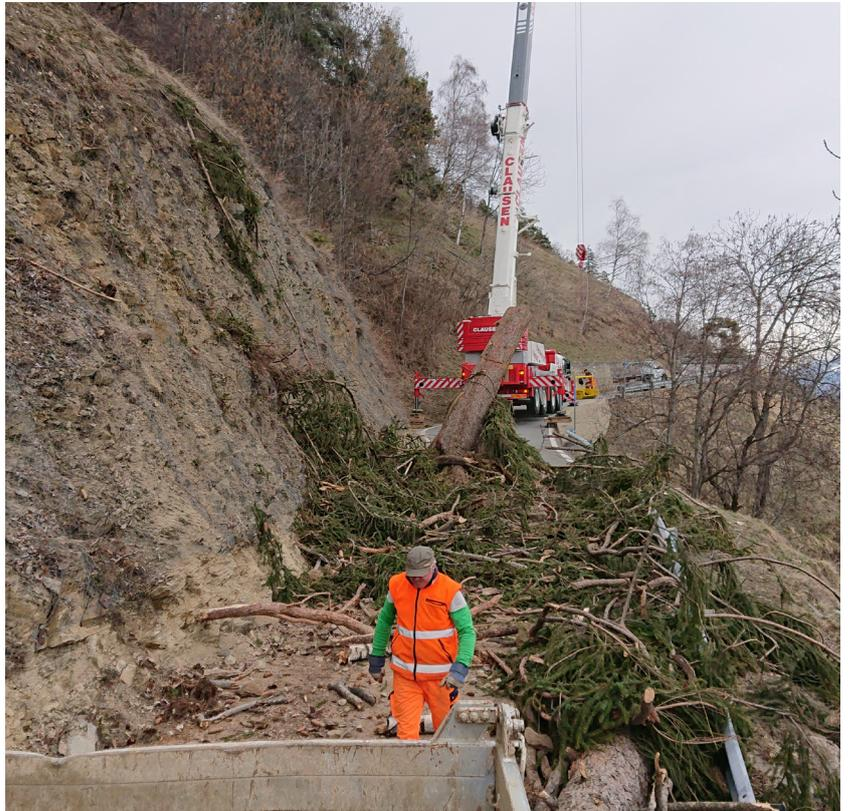
Im Lee bei der Hauptwasserleitung in die Massa wurden grosse Bäume durch den Wind umgerissen und über die Wasserleitung geworfen. Wegen den umgefallenen Bäumen wurde die Wasserleitung teilweise zerstört.
