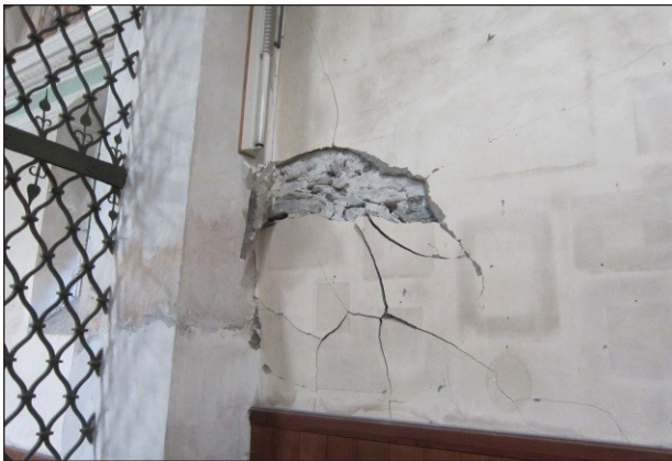
Abb. 3: Wanddurchschlag in der Nordwand im Chor
