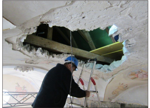
Abb. 4: Instandsetzung Gewölbedurchschlag, März 2013
