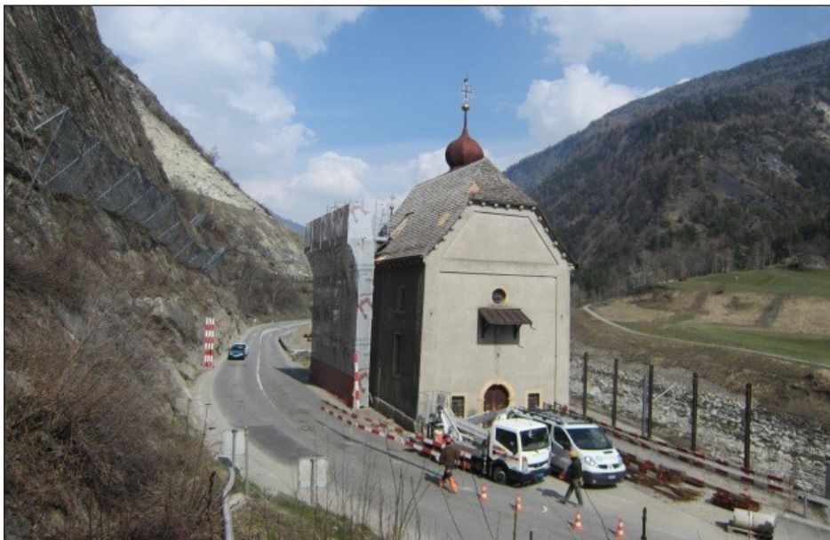
Abb. 5: Kapelle im April 2013, links in der Felswand sind die Steinschlagschutznetze zu erkennen
